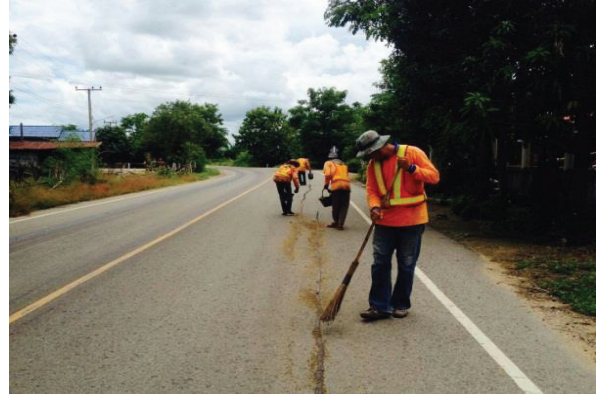
รูปที่ 2.3 การสาดหินฝุ่นหรือทราย และการทำความสะอาดพื้นที่
