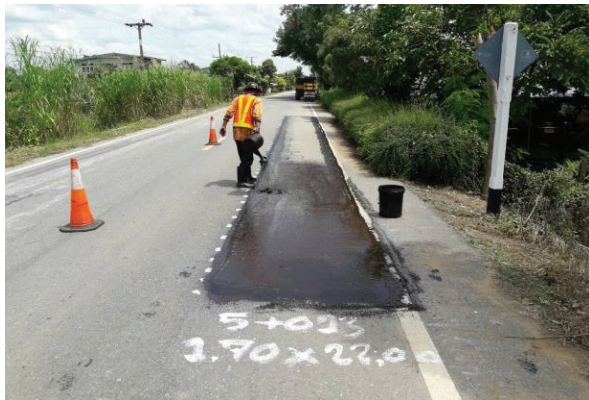
รูปที่ 2.5 Tack Coat พื้นที่ที่จะปะซ่อมและทำการปิดทับด้วยวัสดุ Cold Mix หรือ Hot Mix
