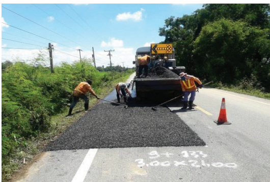
รูปที่ 2.8 นำวัสดุชั้นทางที่เหมาะสมมาก่อสร้างตามข้อกำหนด
