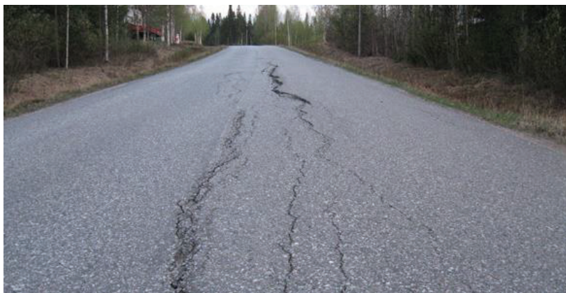
รูปที่ 3.11 ลักษณะความเสียหายของผิวทางลาดยาง ประเภทบวมตัว
