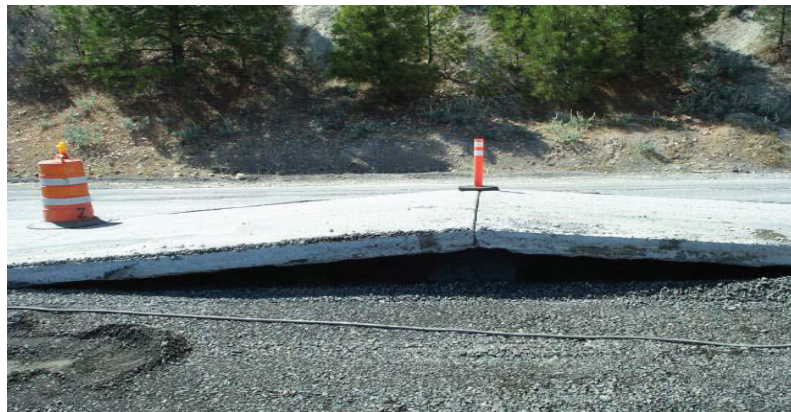
รูปที่ 3.16 ลักษณะความเสียหายของผิวทางคอนกรีต ประเภทแผ่นพื้นโก่งตัว
