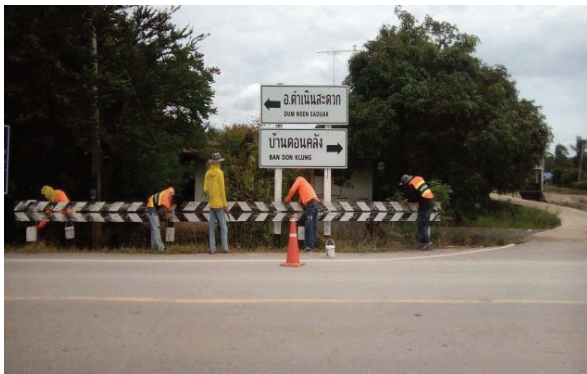
รูปที่ 2.21 การซ่อมแซม ทดแทน และติดตั้ง Timber Barricade
