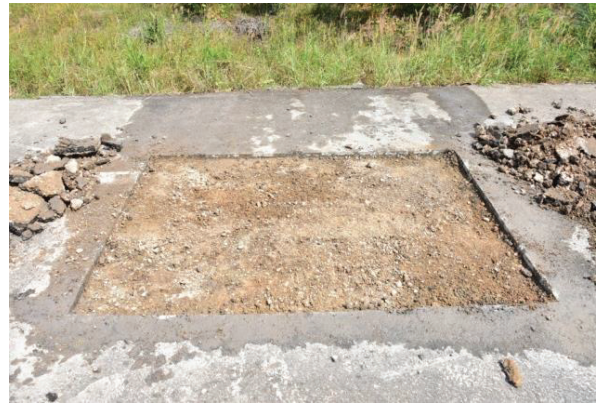
รูปที่ 2.4 ตัดขอบตามพื้นที่ ๆ จะทำการปะซ่อม
