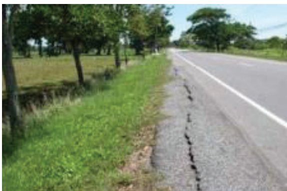
รูปที่ 3.7 ลักษณะความเสียหายของผิวทางลาดยาง ประเภทรอยแตกขอบผิวทางและตามยาว
