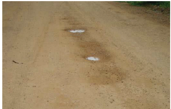
รูปที่ 3.3 ลักษณะความเสียหายของผิวทางลูกรัง ประเภทหลุมบ่อ
