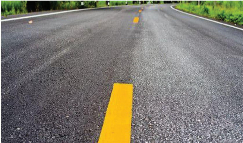
รูปที่ 1.6 ถนนสภาพดี Phase A
