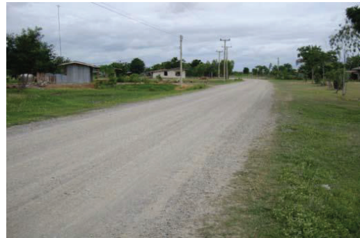
รูปที่ 3.1 ลักษณะความเสียหายของผิวทางลูกรัง ประเภทผิวทางหลุดร่อน
