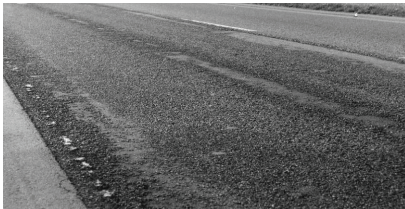
รูปที่ 3.13 ลักษณะความเสียหายของถนนผิวทางลาดยางประเภทสึกกร่อน
