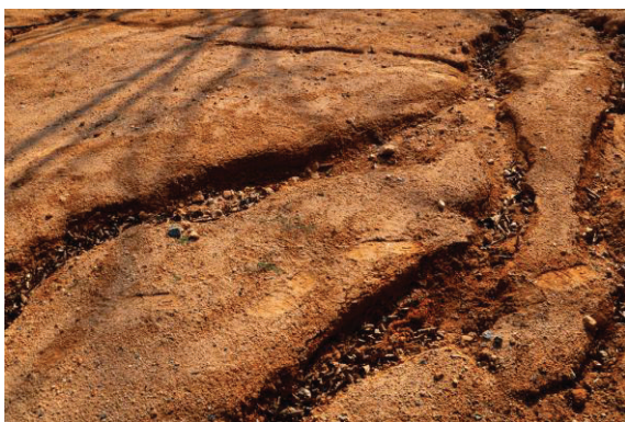
รูปที่ 1.1 การกร่อนแบบริ้วบริเวณผิวถนน (Rill erosion)
