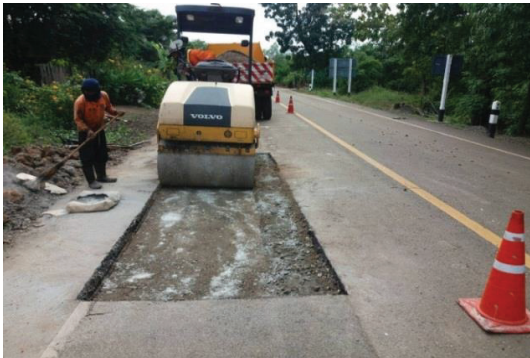
รูปที่ 2.7 บดทับกันหลุมให้มีความเรียบ
