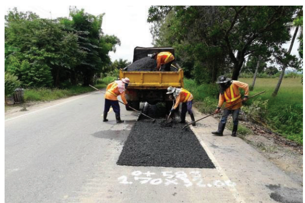
รูปที่ 2.5 Tack Coat พื้นที่ที่จะปะซ่อมและทำการปิดทับด้วยวัสดุ Cold Mix หรือ Hot Mix
