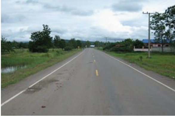
รูปที่ 3.12 ลักษณะความเสียหายของผิวทางลาดยาง ประเภทหลุมบ่อ
