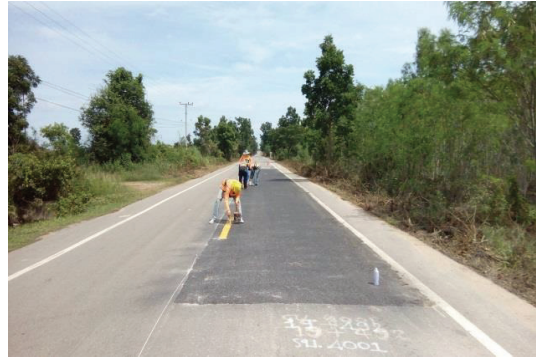
รูปที่ 2.9 ทาสีเส้นจราจรหลังจากดำเนินการทำผิวจราจรแล้วเสร็จ
