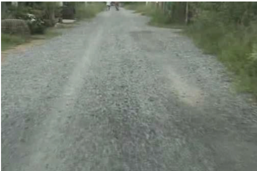
รูปที่ 3.1 ลักษณะความเสียหายของผิวทางลูกรัง ประเภทผิวทางหลุดร่อน
