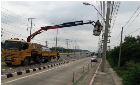
รูปที่ 2.19 การปรับปรุงไฟฟ้าส่องสว่าง
