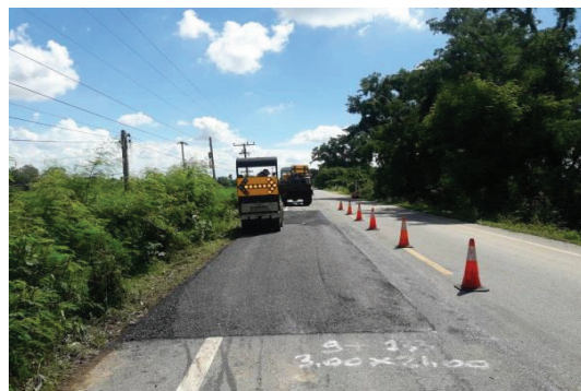
รูปที่ 2.8 นำวัสดุชั้นทางที่เหมาะสมมาก่อสร้างตามข้อกำหนด
