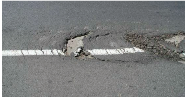
รูปที่ 3.6 ลักษณะความเสียหายของผิวทางลาดยาง ประเภทรอยแตกแบบเลื่อนไถล
