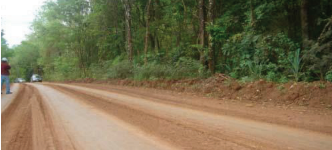
รูปที่ 3.2 ลักษณะความเสียหายของผิวทางลูกรัง ประเภทร่องล้อ
