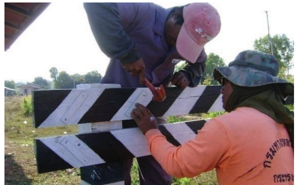
รูปที่ 2.21 การซ่อมแซม ทดแทน และติดตั้ง Timber Barricade
