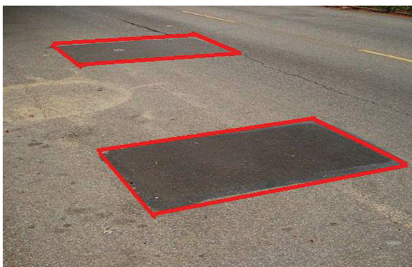
รูปที่ 4.7 ลักษณะความเสียหายแบบรอยปะซ่อมและรูปแบบการวัดพื้นที่ความเสียหาย
