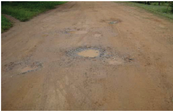
รูปที่ 3.3 ลักษณะความเสียหายของผิวทางลูกรัง ประเภทหลุมบ่อ
