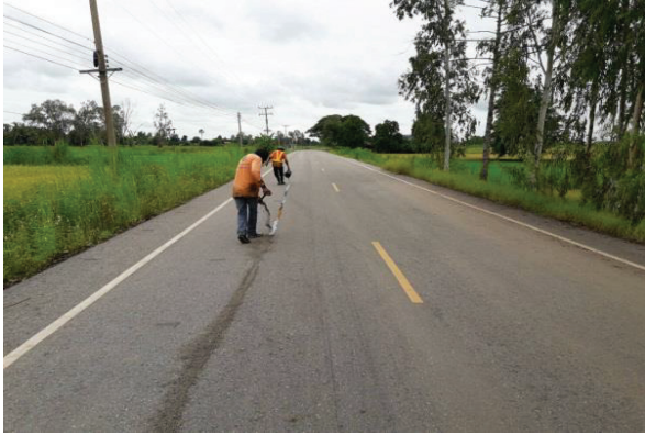
รูปที่ 2.3 การสาดหินฝุ่นหรือทราย และการทำความสะอาดพื้นที่
